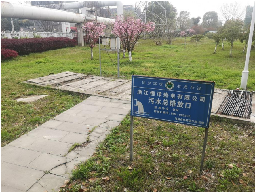
图 11.6-1 生产废水排放口
