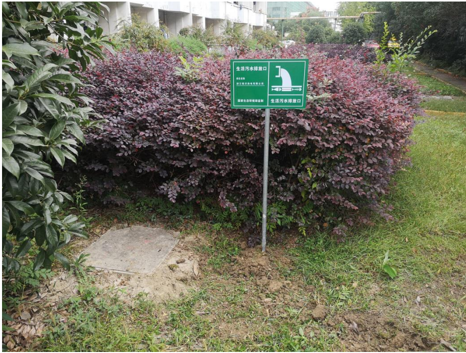
图 11.6-2 生活污水排放口
