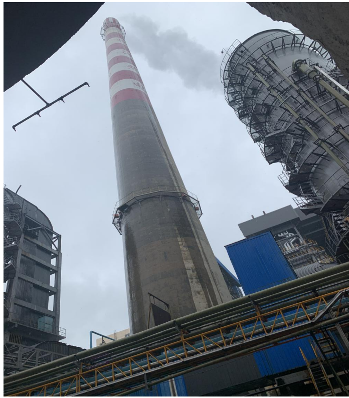
图 11.6-4 锅炉烟气排放口
